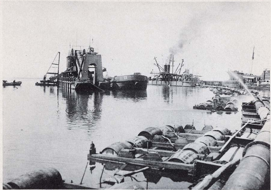
Tren de dragas del interior de la ría
